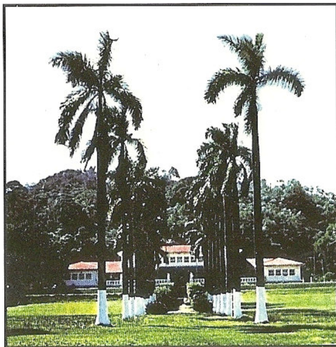
Prédio principal da Panaftosa no município de Duque de Caxias, RJ. (Foto Panaftosa)
