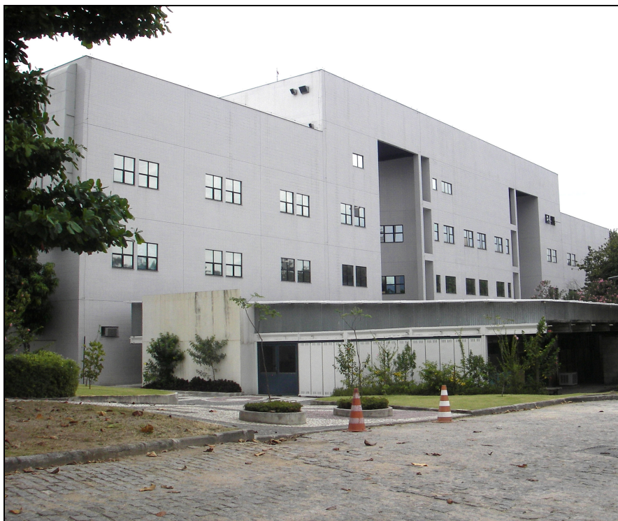
Pavilhão Hélio e Peggy Pereira inaugurado em 2008 na Fiocruz, RJ. (Foto Monika Barth/IOC)
