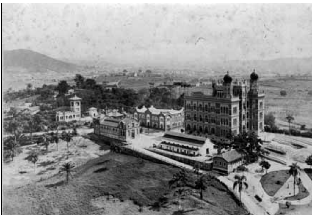
Pavilhão Mourisco e as primeiras construções e laboratórios do Instituto Oswaldo Cruz. (Acervo da COC)
